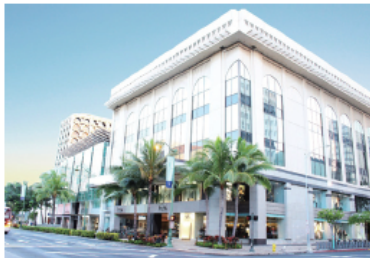
ワイキキの中心、カラカウア通りとシーサイド及びロイヤルハワイアン通りのブロックに建つ6階建てのビルワイキキショッピングプラザ
